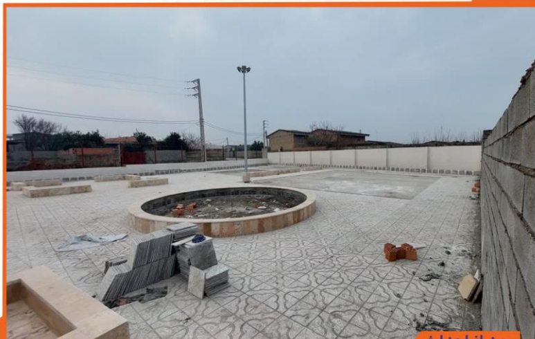
بعد از احداث
