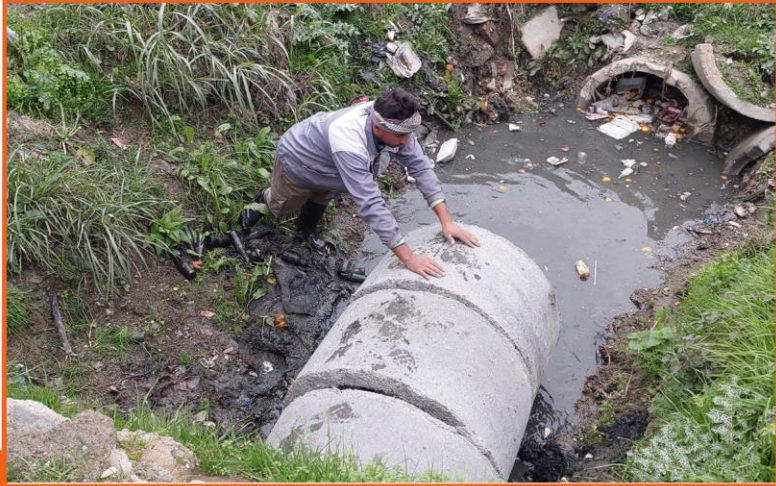
احداث کانالهای بتنی جهت دفع آبیهای سطح شهر
