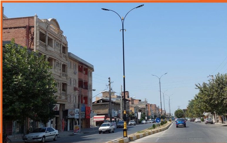
نصب تیرهای برق دکوراتیو
